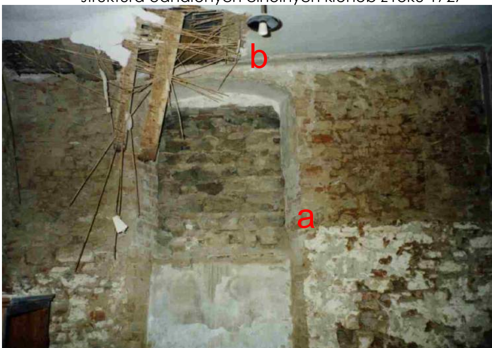
8 zadní stěna domu se zazděným oknem v místnosti č. 18 v patře a – zaslepené okno před překrytím novou plentou b – omítaný rákosový podhled stropu
